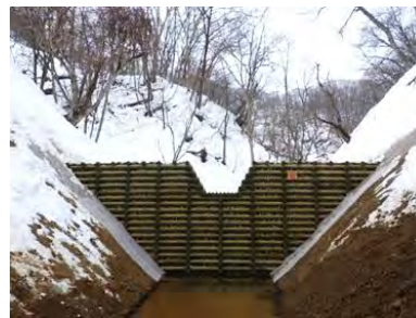
校倉式の治山ダムの全景
