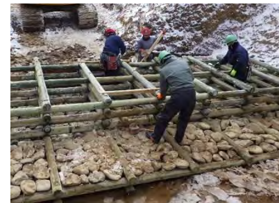
施工中の様子
