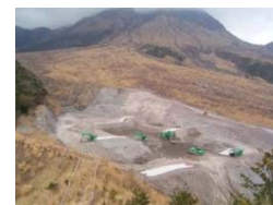
異常堆積した火山灰土の排土
