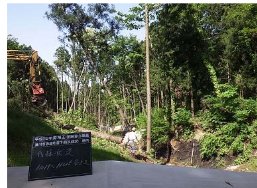
立木の伐採作業(群馬県渋川市)
