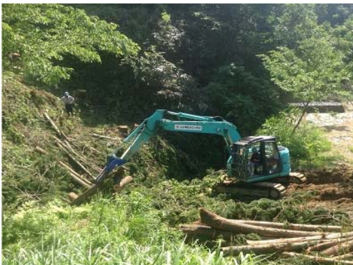
危険木の除去作業(新潟県上越市)
