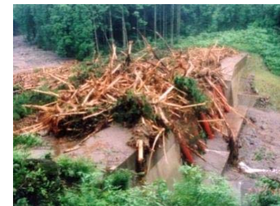
流木捕捉式治山ダムの設置
