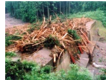
流木捕捉式治山ダムの設置
