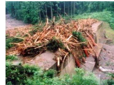
流木捕捉式治山ダムの設置
