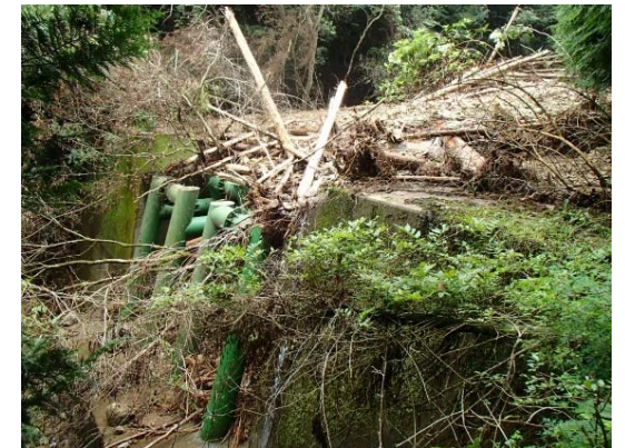
治山施設(透過型治山ダム)の流木の捕捉状況(佐田地区)
