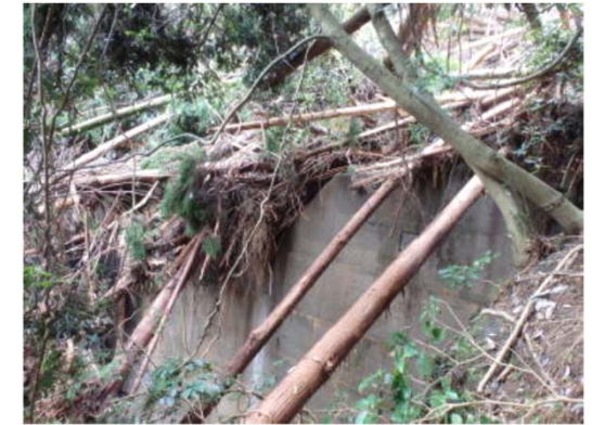
治山施設において崩壊土砂・流木の捕捉を確認
