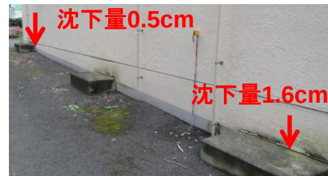
地面が沈下し建物がゆがみ、各所に亀裂が生じている特殊実験棟
