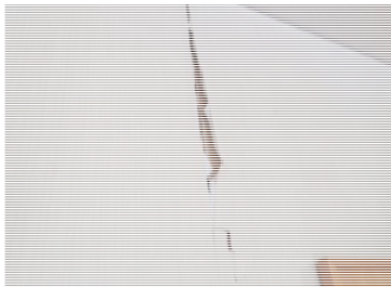
壁面の亀裂
