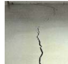
床面の亀裂
