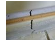
地面が沈下し建物がゆがみ、各所に亀裂が生じている特殊実験棟
