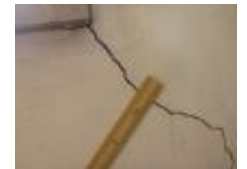
地面が沈下し建物がゆがみ、各所に亀裂が生じている特殊実験棟
