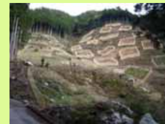
パッチディフェンスの設置 (平成22年11月撮影)
