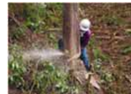
スギ立木の伐倒・除去
