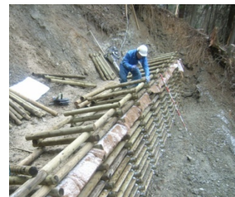
木製土留工施工中の様子
