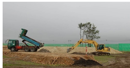
盛土工事の様子
