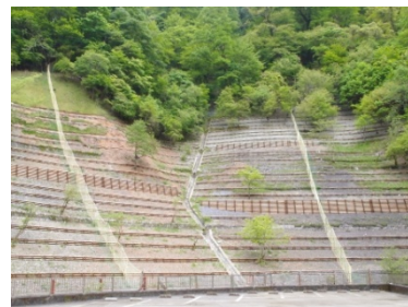
間伐材丸太を活用した山腹工
