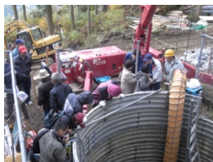
工事施工地の現地説明会の様子
