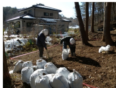
落葉等の堆積有機物除去の様子
