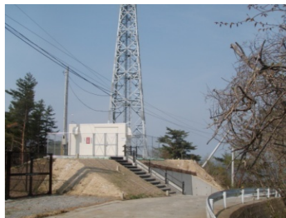
消防救急デジタル無線基地局の用地として貸付された国有林野
