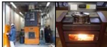
木くず焚きボイラー、ペレットストーブ、石炭混焼 等
