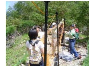
防護柵の設置
