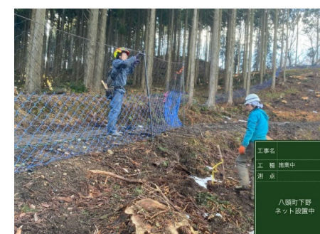
＜シカ防護ネット設置＞
