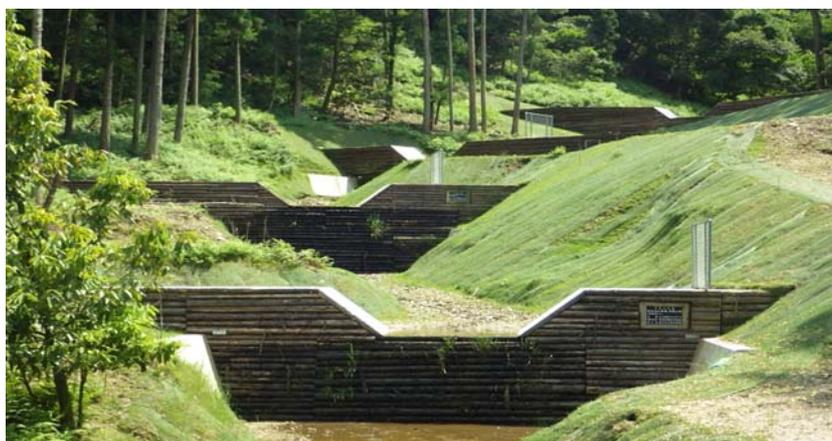
丸太式残存型枠工（広島県竹原市）
