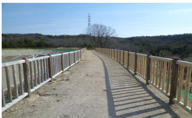
地域用水環境整備事業による転落防止柵 (愛知県日進市)
