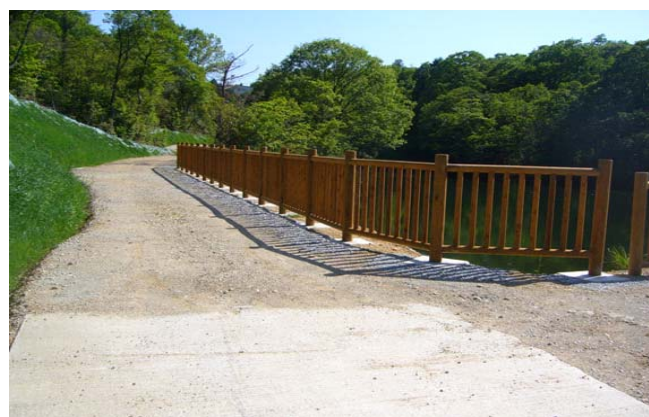
ため池等整備事業による木柵 (兵庫県小野市)
