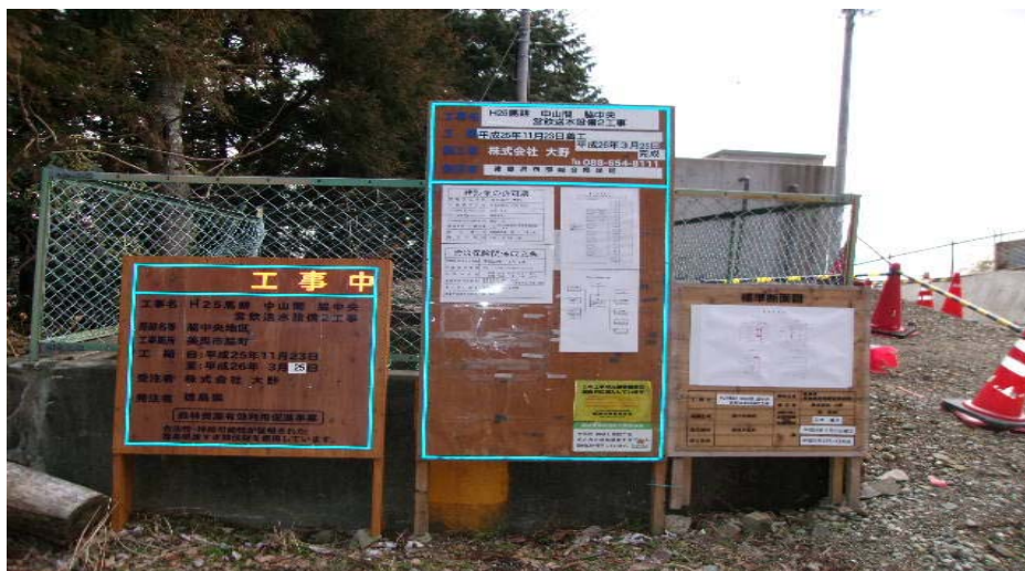
中山間地域総合整備事業による工事用看板（徳島県美馬市）
