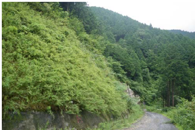
チップの植生基材吹付工
