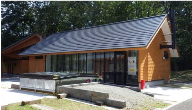
設備棟とチップヤード(手前)
