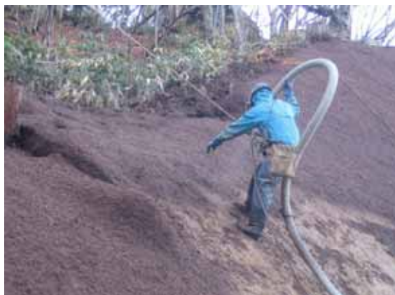
チップの植生基材吹付工
