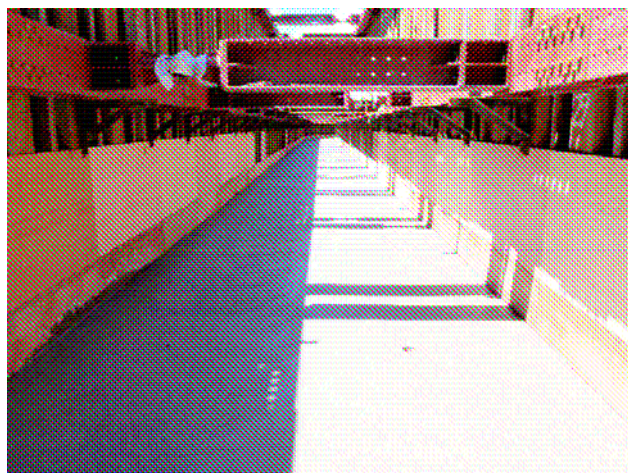
農地防災工事の残存型枠（徳島県板野町）
