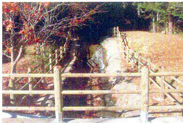
木柵(山梨県富士川町)
