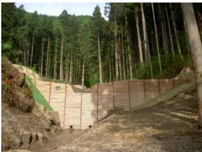
治山工事の残存型枠（福島県郡山市）
