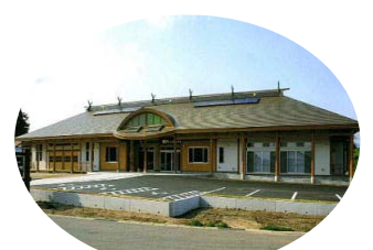
木造公共施設
