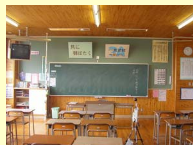
(D) 内装の全面に木材を使用した 鉄筋コンクリート造校舎の例
