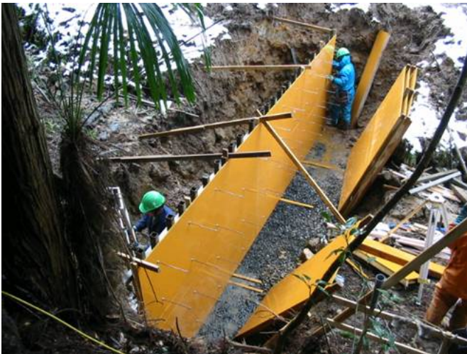
木製残存型枠工（島根県）
