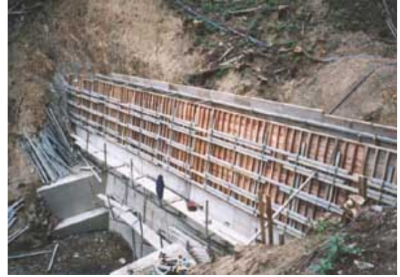
まく板型枠工（滋賀県）
