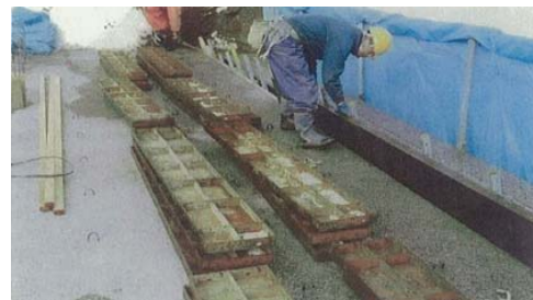
(左,上)鋼製型枠工
