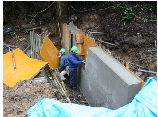
(左,上)スギ間伐材合板型枠工（島根県）
