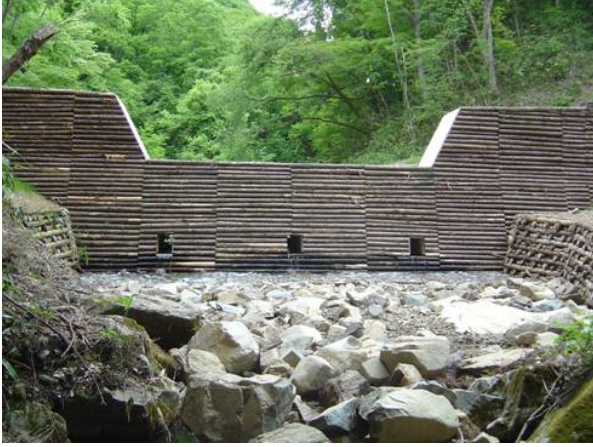
木製残存型枠工（島根県）
