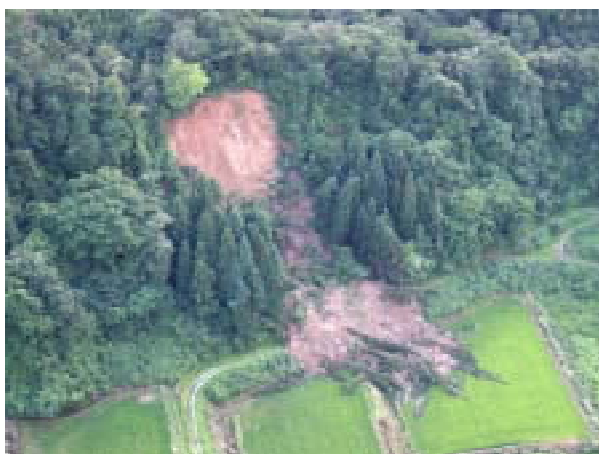
新潟県中越沖地震による被害（新潟県長岡市）
