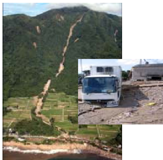
台風第4号による被害（鹿児島県南大隅町）
