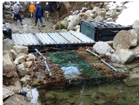
鋼製枠と布団かごの設置状況
