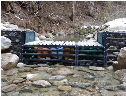
鋼製枠と布団かごの設置状況
