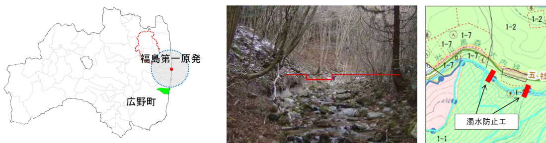
濁水防止工の設置箇所
