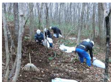
落葉等除去作業
