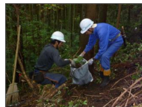
土のう袋詰め作業
