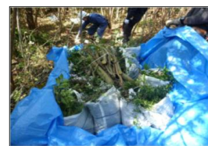
土のう袋等詰め作業
