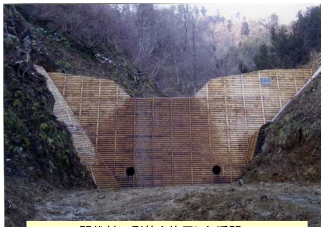
間伐材の型枠を使用した溪間工 〔秋田県秋田市〕 東北森林管理局 秋田森林管理署
