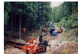
小型タワーヤードによる集材作業
