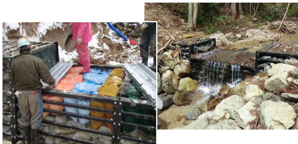
吸着材を使用した濁水防止工
