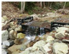
施工後の状況
