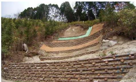
間伐材の型枠を使用した山腹工
