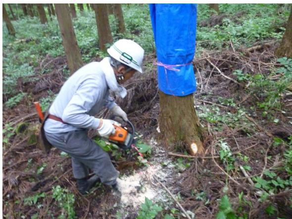
写真4 伐採時の汚染防止のための養生
