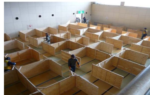
避難所で合板製の間仕切りを設置(宮城県栗原市)
