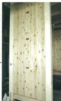
角材を連結させたパネル「壁柱」
