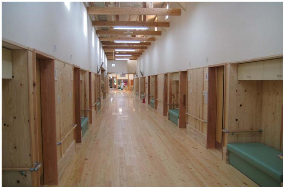
床板はヒノキを活用し、柱・梁をスギ材の現しとする。居室内部、手摺にも木材を使い、木に触れる機会を創出している。
