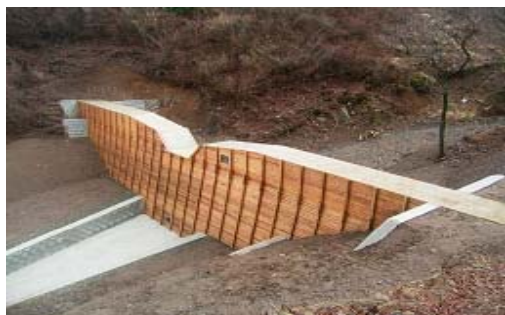
コンクリート谷止工の残置式型枠
