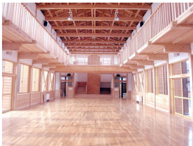
交流広場の吹き抜け空間 (合掌による小屋組み)
