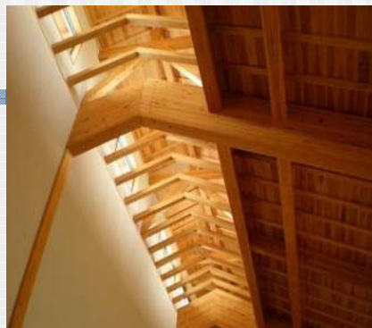
「高窓」部を内部から見上げる
