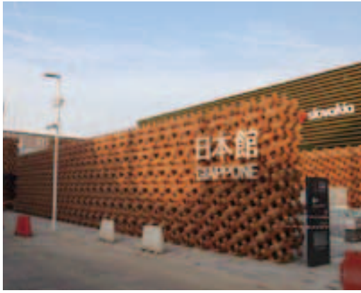
国産カラマツ集成材を活用した ミラノ国際博覧会日本館の外壁
