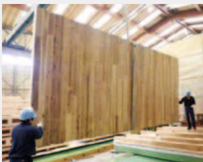
工場での CLT 生産
