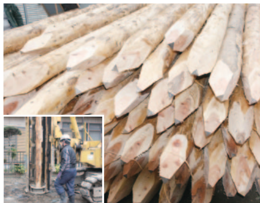
間伐材を用いた木杭
