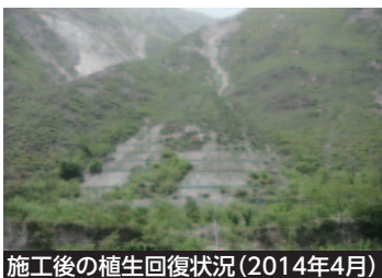
施工後の植生回復状況 (2014年4月)
