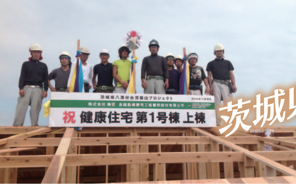
宜蘭市の第一棟上棟式(平成26年11月)
