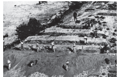
人力での工事施工風景 (つるはしによる掘削、客土の採取・運搬等)
