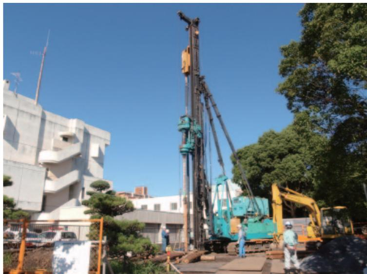
液状化の発生を抑制する丸太打設の状況(千葉県浦安市)
