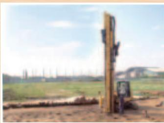
丸太打設軟弱地盤対策(千葉県浦安市)
