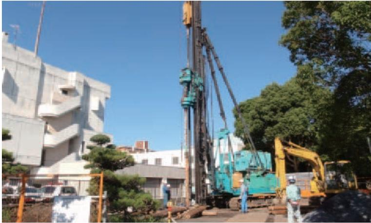
国産材の丸太杭施工(写真提供：飛鳥建設(株))
