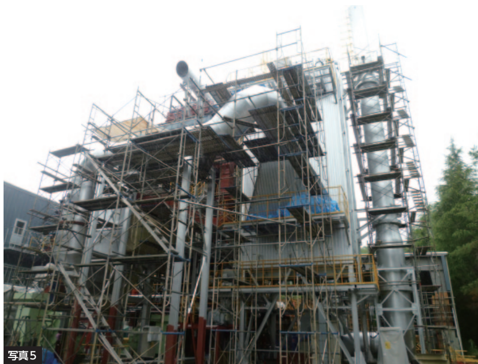
建設中の木質バイオマス発電所
