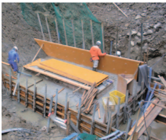
コンクリート型枠への利用
