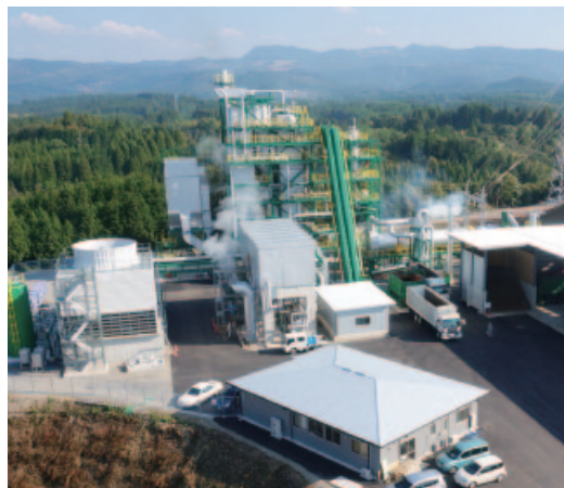
株式会社グリーン発電大分 天瀬発電所(大分県日田市)
