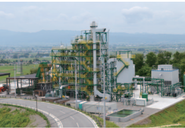
株式会社グリーン発電会津 河東発電所(福島県会津若松市)
