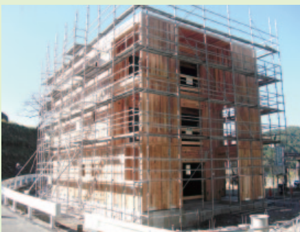
CLTで建築中の3階建て社員寮(高知県長岡郡)
