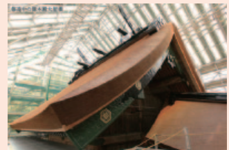
檜皮が葺かれた御本殿大屋根
