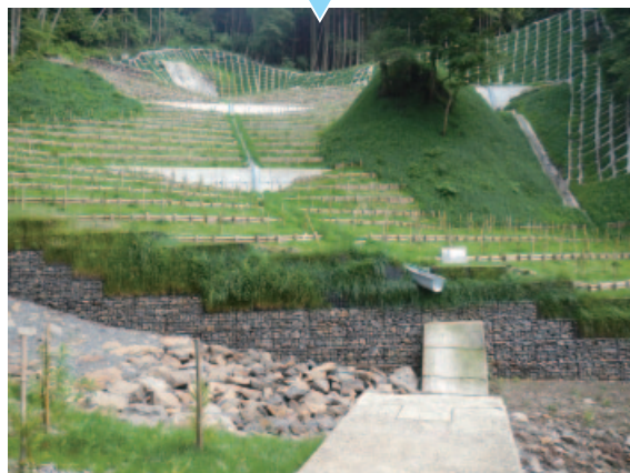
治山事業による崩壊地の復旧状況(佐賀県伊万里市)
