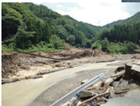
平成25年7月 梅雨前線豪雨によりJR・県道等が被災(島根県津和野町)
