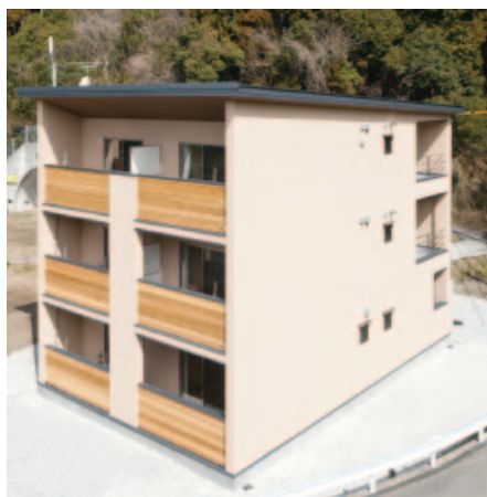
建物外観 (写真提供：高知おおとよ製材株)
