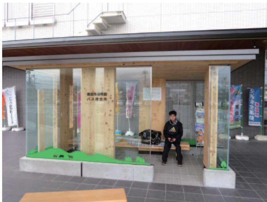
地元産ヒノキのCLTを活用したバス待合所。内部のベンチにもCLTパネルが使用されています。(写真提供：真庭市)
