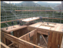
3階床の施工状況
