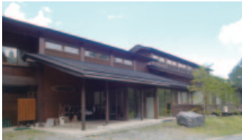
スギ大断面集成材を使用した寄宿舍棟 (愛機荘)の外観
