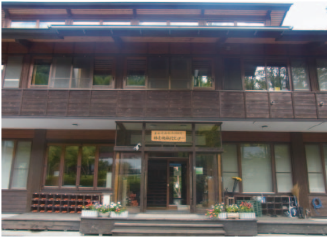
カラマツ大断面集成材を使用した事務所棟
