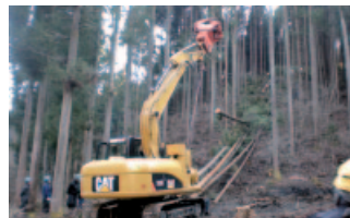
油圧ショベルをベースマシンとしたスイングヤード。
