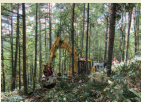
高性能林業機械による路網作設(根釧西部森林管理署)
