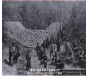
山梨県三ツ澤治山堰堤
