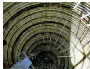
集水井工により地下水を排除
