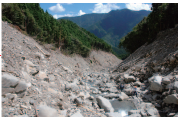
土石流による被災状況
