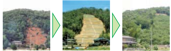
山腹工事による森林の復旧・再生(兵庫県篠山市)
