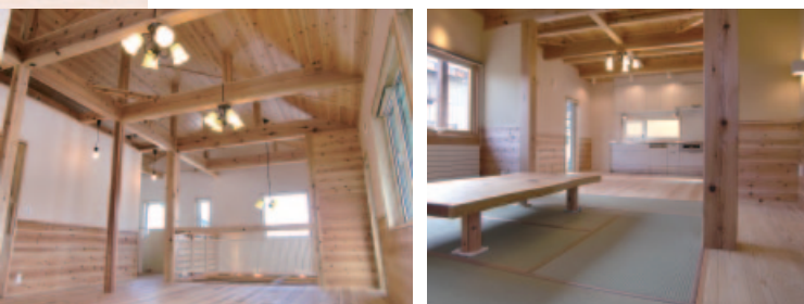
国産スギ材を使った民家の内装の施工例
