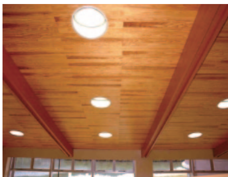
国産スギ材を使った天井の施工例 (大分県臼杵市立北中学校)
