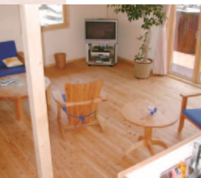
カラマツを使用した床の施工例
