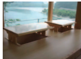
ヒノキ集成材を使用した内装の施工例
