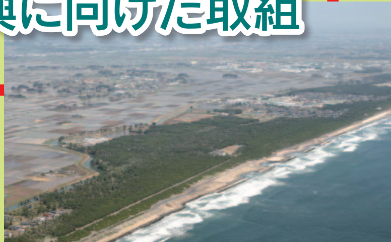
被災前の海岸防災林(宮城県岩沼市)平成18年撮影
