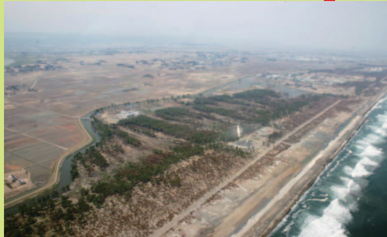
被災後の海岸防災林(宮城県岩沼市)平成23年撮影
